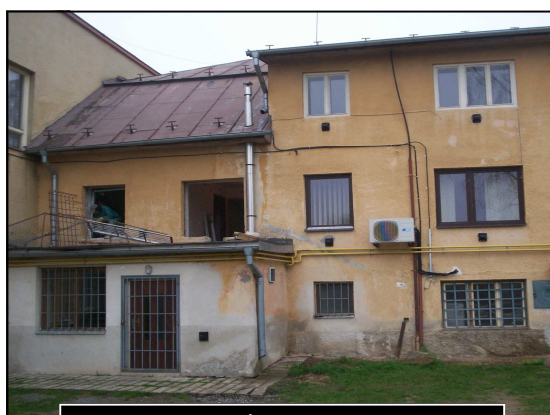
Zadná časť OĽÚ pred rekonštrukciou
