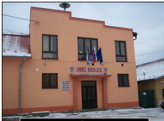
Predná časť OĽÚ po rekonštrukcii
