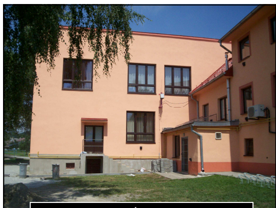
Zadná časť OĽÚ po rekonštrukcii
