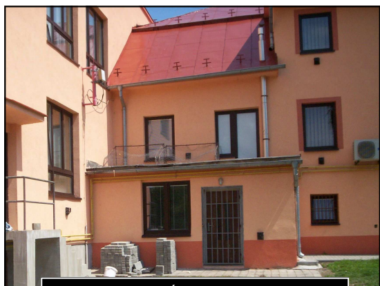
Zadná časť OĽÚ počas rekonštrukcie
