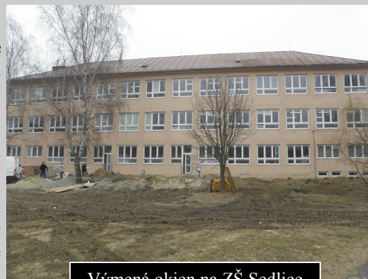
Výmena okien na ZŠ Sedlice
