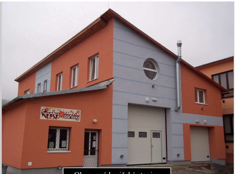
Obnovená hasičská stanica
